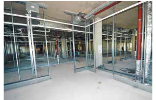
Der Einbau des Zentral-OP hat begonnen
