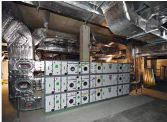
Der Einbau der Haustechnik läuft auf Hochtouren
