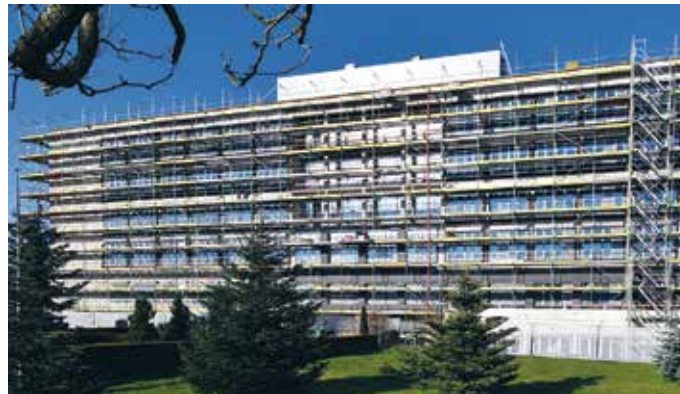
Sämtliche Außenfenster sind eingebaut
