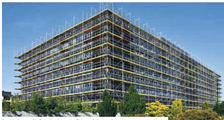
Der Neubau verläuft nach wie vor im Zeit- und Kostenplan
