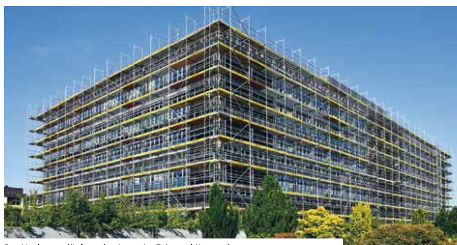
Der Neubau verläuft nach wie vor im Zeit- und Kostenplan
