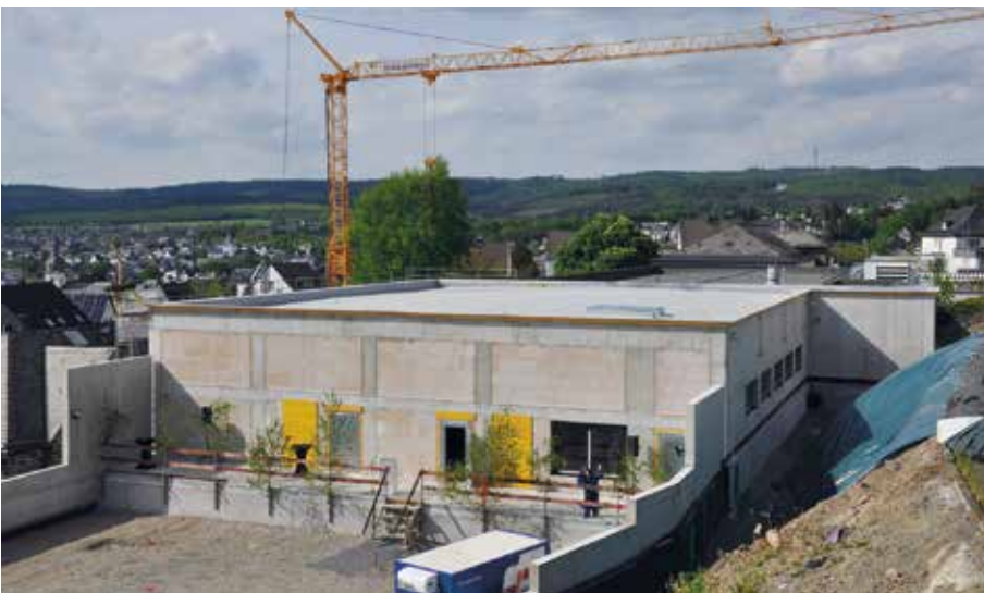
Der Erweiterungsbau der künftigen Zentralküche beim Richtfest im Mai 2022
