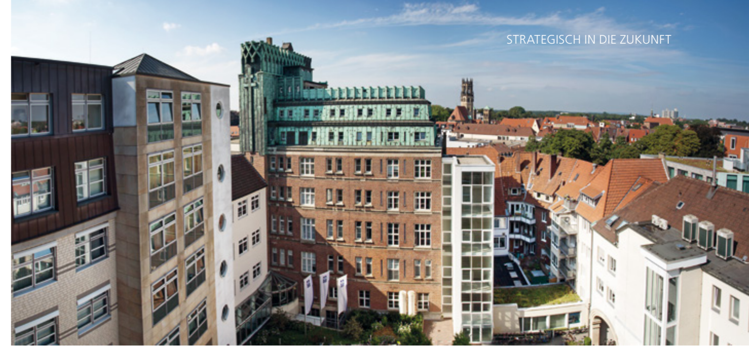
Die Raphaelsklinik wurde 1908 von den Clemensschwestern im Herzen der Stadt Münster errichtet. Der 1930 gebaute äußerst markante Turm mit dem Kupferdach steht heute unter Denkmalschutz. Die dunklen Flecken sind ausgebesserte Einschlagstellen von Bombsplittern aus der Zeit des Zweiten Weltkriegs. Heute sichert die Raphaelsklinik als einziges Krankenhaus im Stadtzentrum die medizinische Versorgung in Münsters Innenstadt
