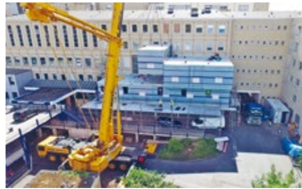
In einer mehrtägigen Aktion wurden die Gebäudemodule montiert
