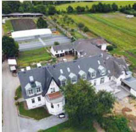
Im Vordergrund der Altbau nach der Sanierung, im Hintergrund das neue Gewächshaus
