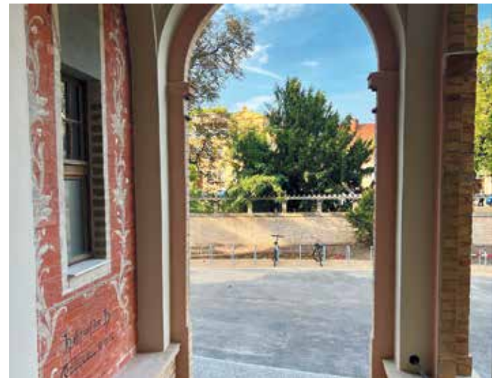
Saniertes Eingangsportal mit wiederentdeckter Wandbemalung
