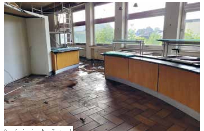
Das Casino im alten Zustand
