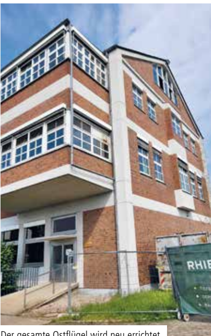
Der gesamte Ostflügel wird neu errichtet
